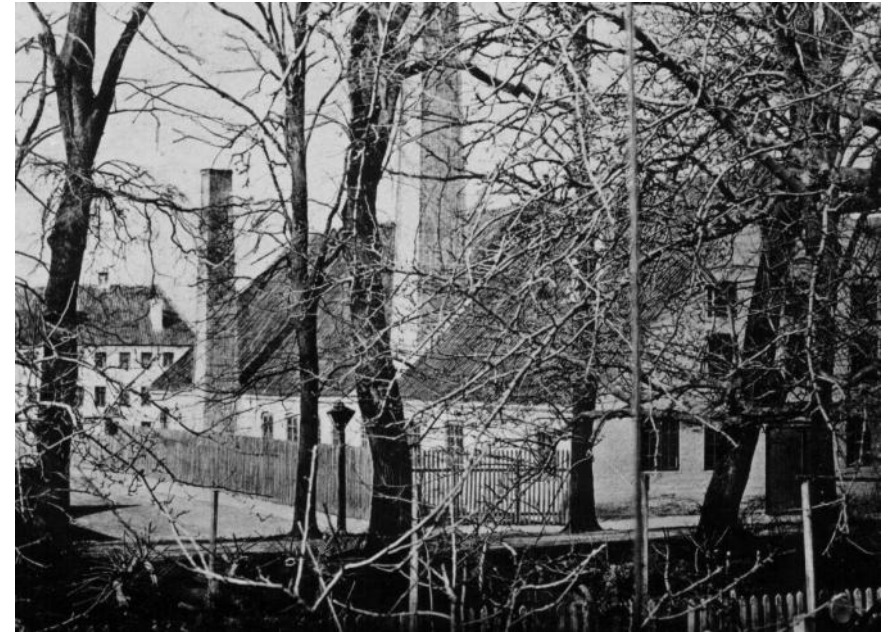
Kobbervålseværket (3.7) med de imponerende skorstene. I forgrun- den kanalen.
