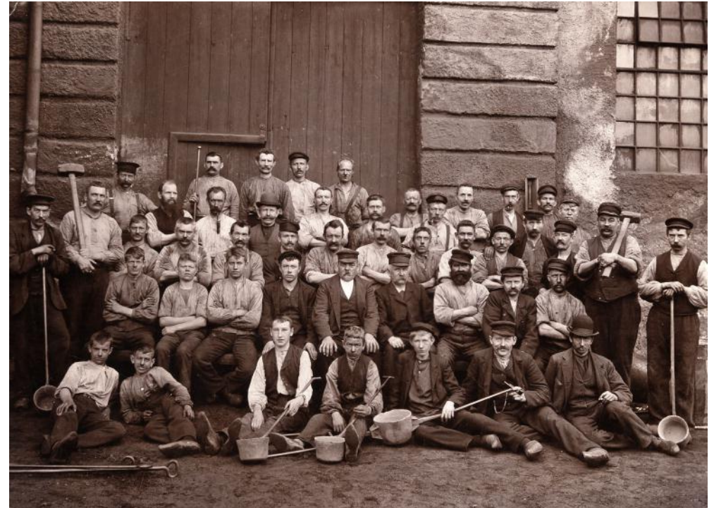
Arbejderne og enkelte mestre er opstillet til lejligheden foran Gjethuset omkring 1900. Bemærk de sodsværtede arbejdsdrengs i forgrunden.
