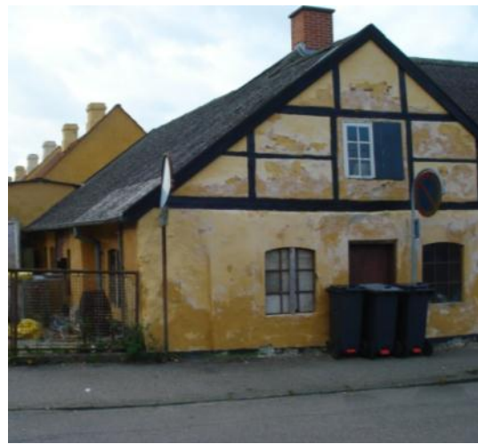
Den gamle smedje i Allégade, heri indgår nogle af de få bygningselementer vi ken- der fra det Classenske arkadebyggeri (3.3).
